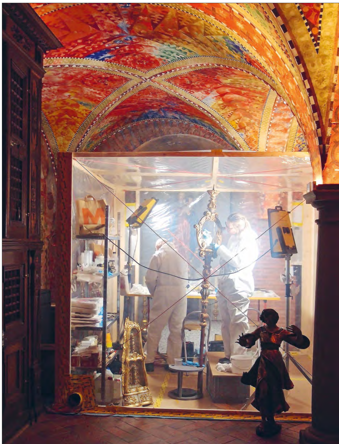
Die Restauratoren an der Arbeit in der Box, in der ein leichter Unterdruck herrscht. Foto: Urs-Beat Frei
